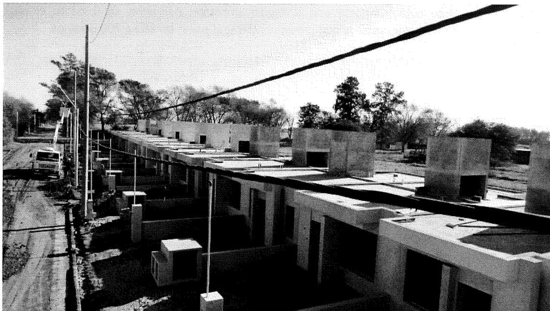
Banco de Tierras Municipal: acompañando el proyecto de urbanización de 61 nuevos lotes, se extendieron 400 mts de línea de media tensión con cable protegido, se instaló una subestación con transformador de 250 kva y se completó la obra de baja tensión, con la colocación de 15 postes de retención, 20 postes de alineación y el tendido de 800 mts de cable preensamblado. Además, se instalaron 16 luminarias led de Alumbrado Público.
